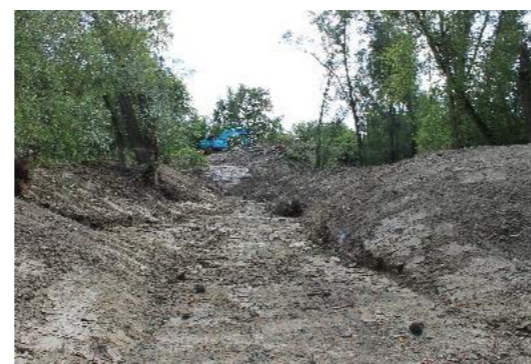
Partie médiane de l'annexe, vue aval, 2018
