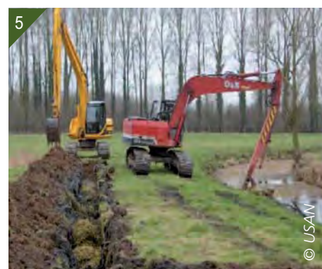
2- Godet grillagé. 3- Secteur avant intervention. 4- Secteur après intervention. 5- Arrachage mécanique.
