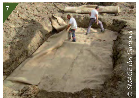
3- Arrachage manuel de renouée. 4- Broyage des matériaux en 2 à 3 passes dans le godet. 5- Rotor et barre de broyage du godet. 6- Broyage réalisé dans la fosse d'extraction. 7- Matériaux recouverts d'un feutre biodégradable.
