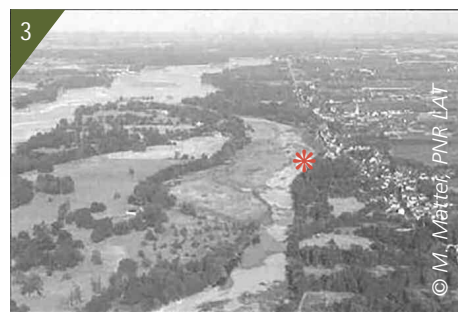
3 - Vue aérienne du site d'intervention.
