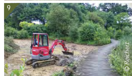
4 et 5 - Étang Acigné 02 avant intervention.
