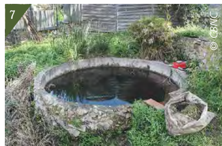
7 - Le bassin de Lumiu après intervention.
