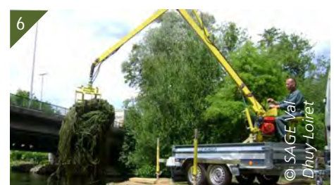
3 et 4 - Râteau hydraulique motorisé (Ratodo). 5 - Plantes chargées sur une barge ostréicole. 6 - Mini-grue pour décharger les plantes dans une benne (plucker).
