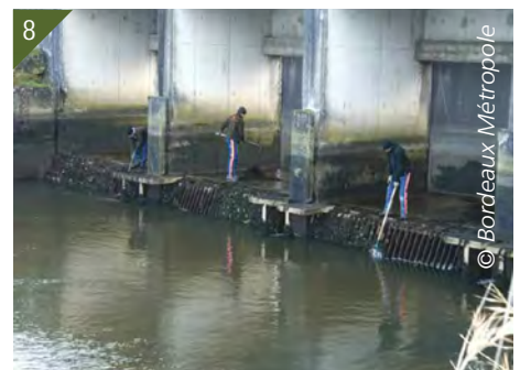
7 - Arbres implantés sur les berges de la jalle. 8 - Opérations de nettoyage manuel des débris d'E. densa sur les ouvrages hydrauliques.
