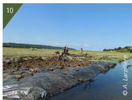
9 et 10 - Pose de bâches.
