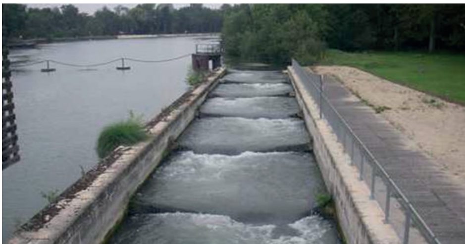
Passe à poissons du barrage de Jaulnes ©FD77
