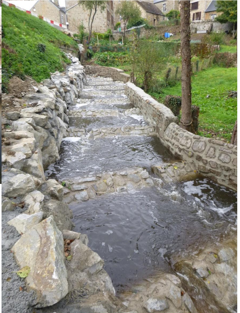
Figure 27 : Après les travaux, septembre 2018.
