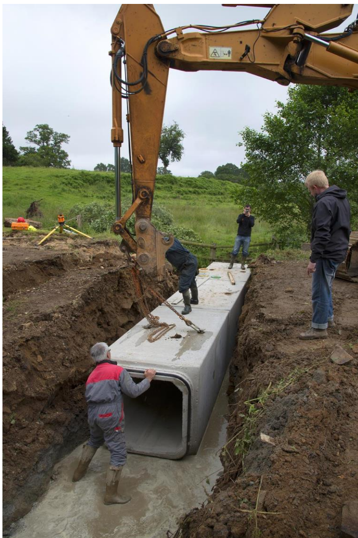
Figure 8 : Remplacement par un pont cadre en 1*1 m (entreprise Elie).
