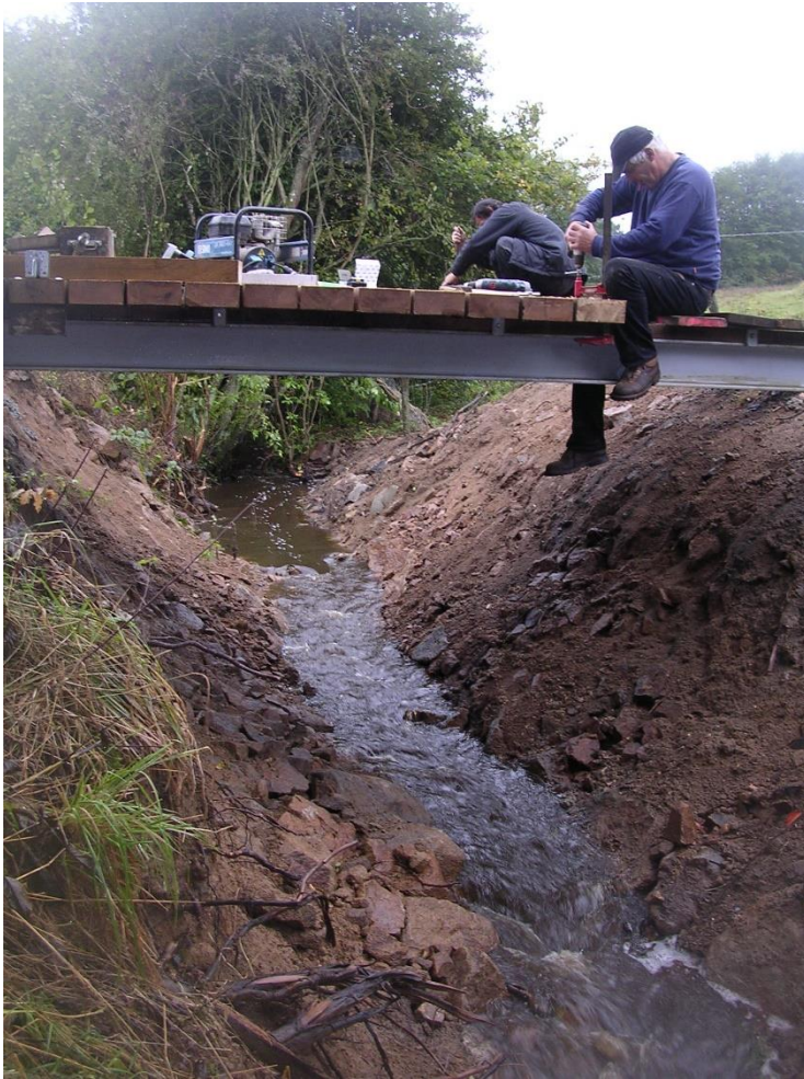
Figure 11 : Remplacement par une passerelle engin, 2012, réalisée par l'AIFR et entreprise Jarry.
