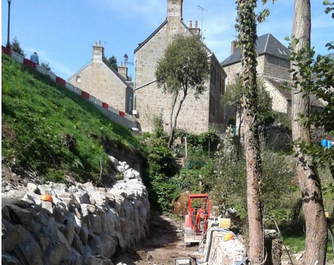
Figure 26 : Pendant les travaux du CD61, juillet 2018.
