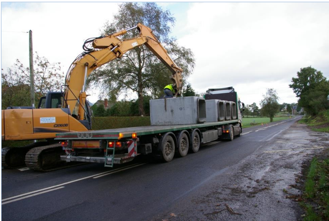
Figure 18 : Déchargement des 7 modules (Bonna Sabla), 2014
