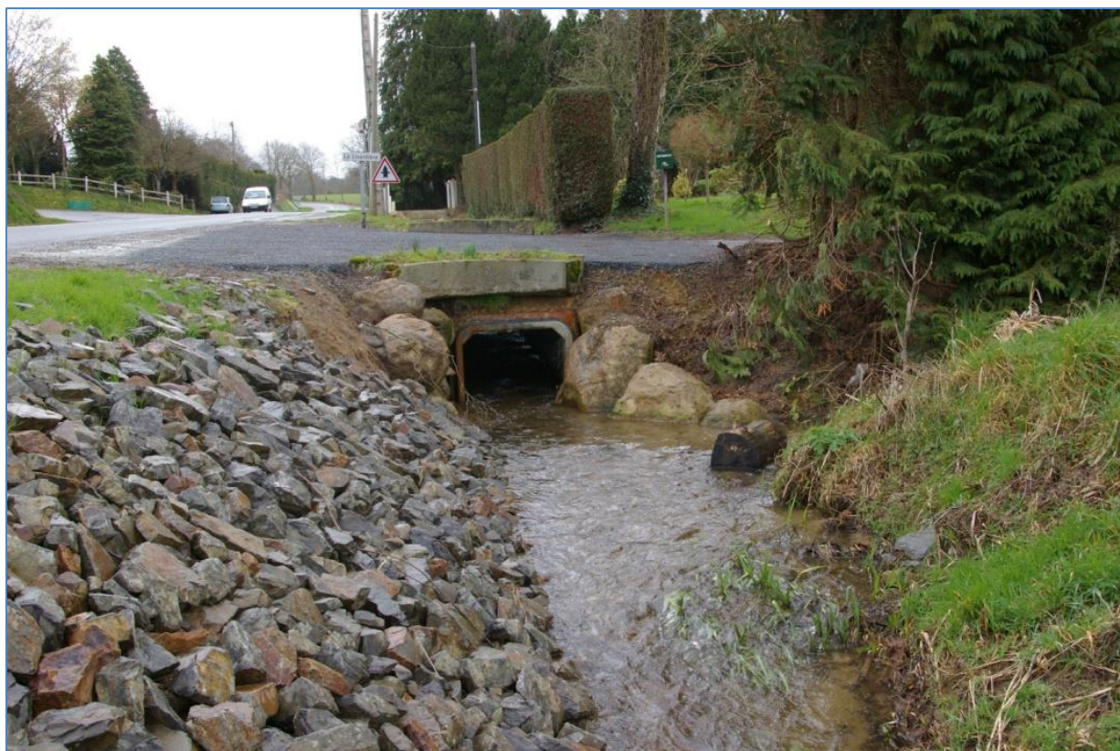
Figure 21 : Pont cadre, 2014
