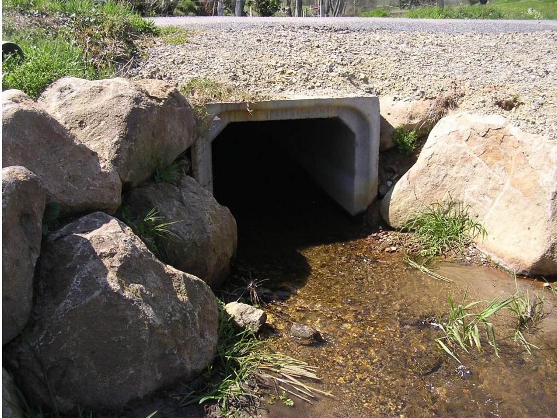
Figure 9 : Pont terminé, 2012, route de la Marchandière.
