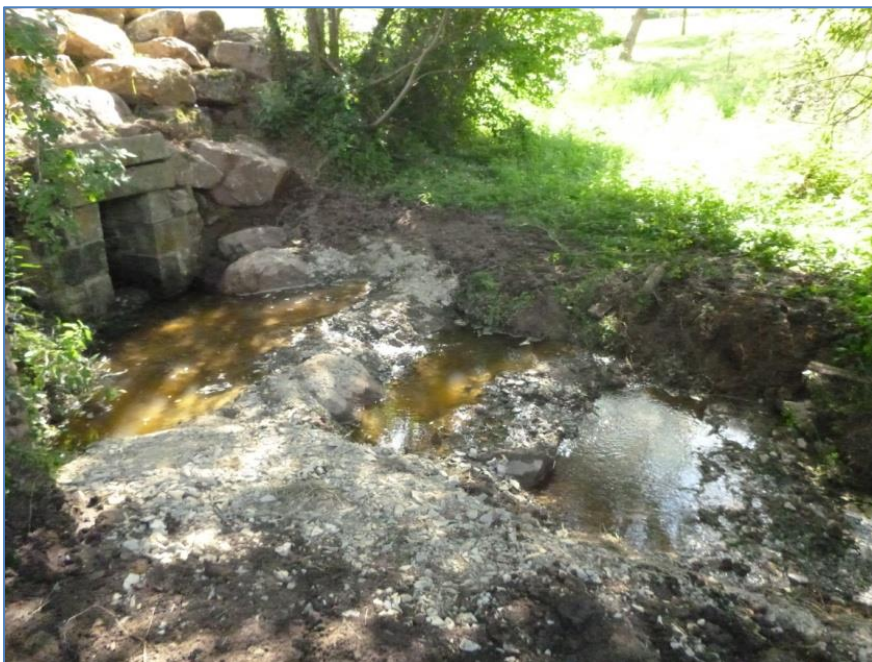
Figure 14 : Création des pré-bassins en blocs (800 mm), 2013.
