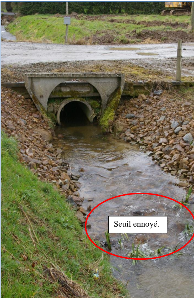
Figure 20 : ennoisement d'une buse par un seuil.
