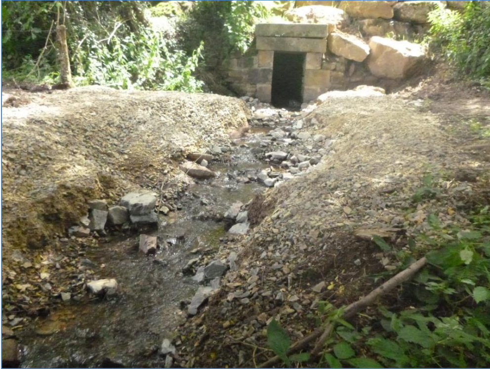
Figure 15 : Trois semaines après la fin du chantier.
