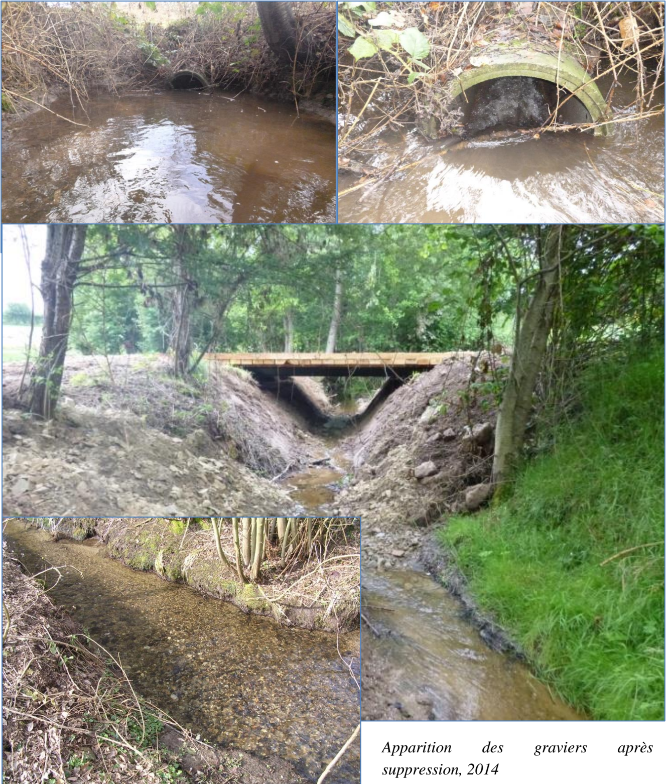
Figure 23 : Remplacement d'une buse par une passerelle, 2014.
