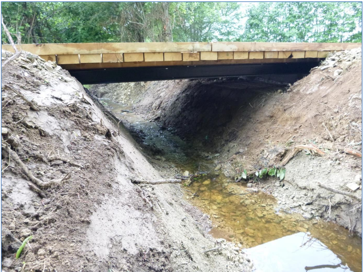
Passerelle sur la Ferronière, 2014.
