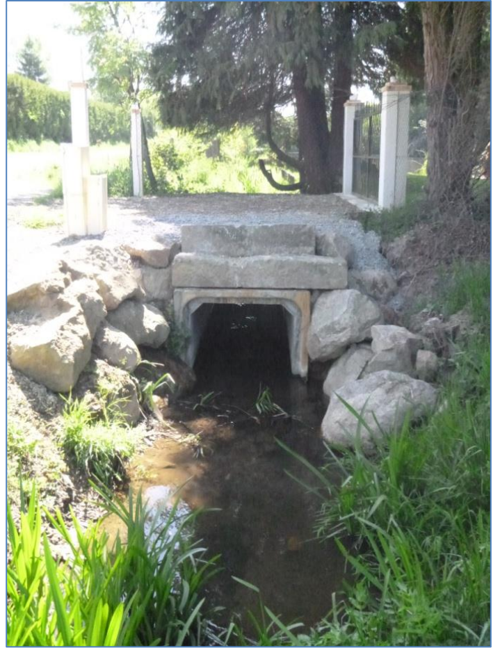
Figure 17 : Buse après travaux, fin 2014
