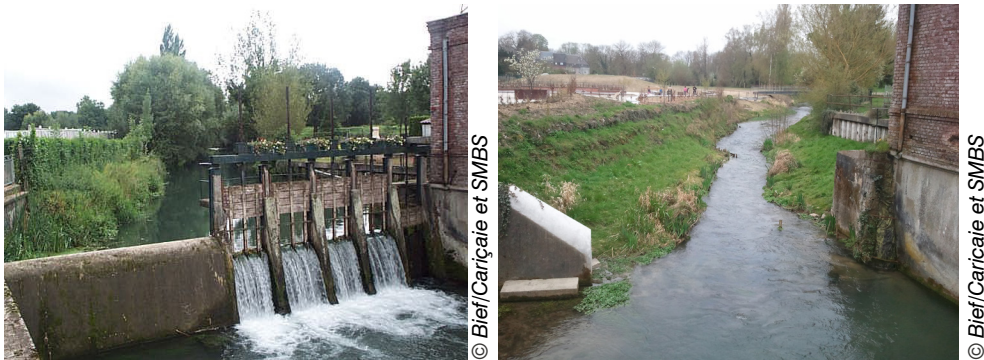
Figure 14. Effacement d'ouvrage sur la Selle au Cateau-Cambrésis (59). À gauche, vue du seuil avant travaux (2009), à droite, situation deux ans après travaux (2012). Remarquer le mur d'habitation en rive gauche et le muret du seuil en rive droite, en partie conservé, en points de repère.
